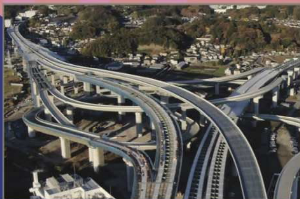
見学場所「午前」 「横浜環状南線(仮称)米」 (横浜市栄区)
