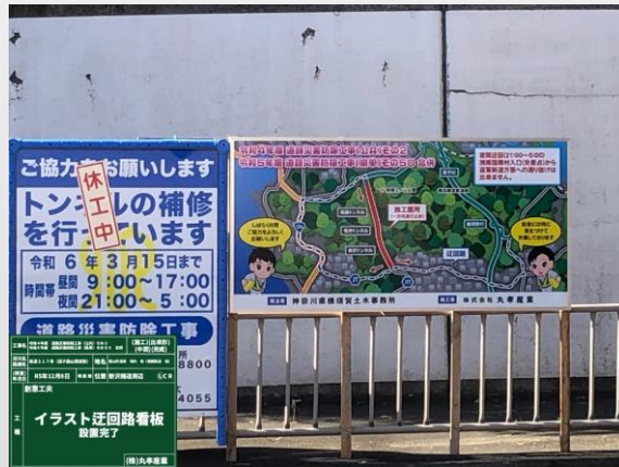
イラスト迂回路看板設置
