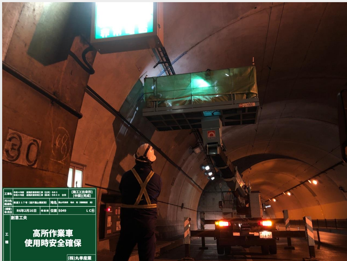
高所作業車安全確保
