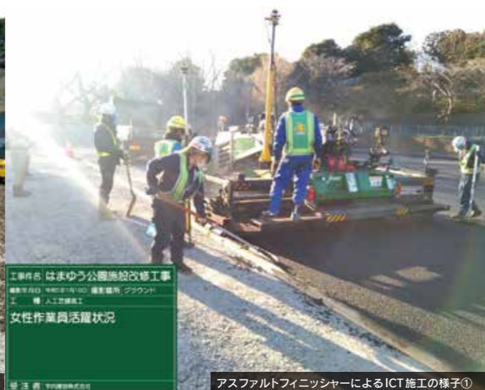
アスファルトフィニッシャーによるICT施工の様子①
