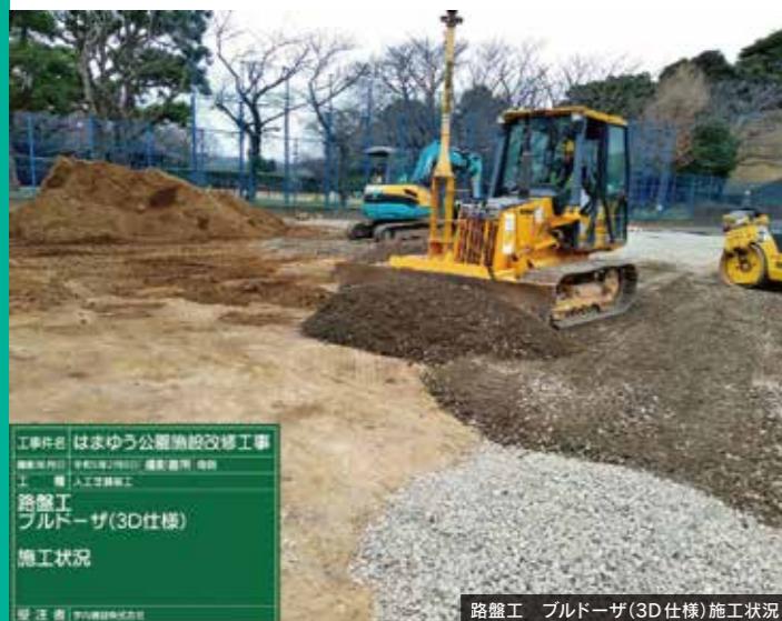
路盤工 ブルドーザー(3D仕様)施工状況
