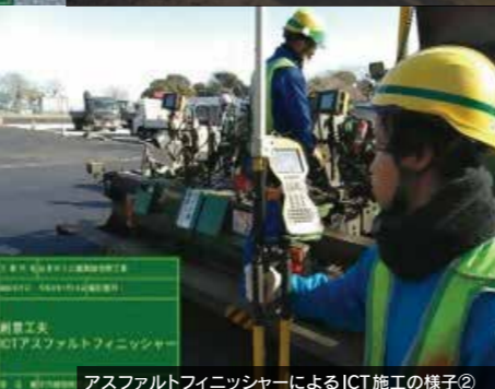
アスファルトフィニッシャーによるICT施工の様子②
