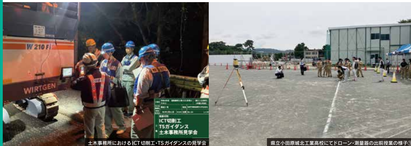
土木事務所におけるICT切削工・TSガイダンスの見学会
