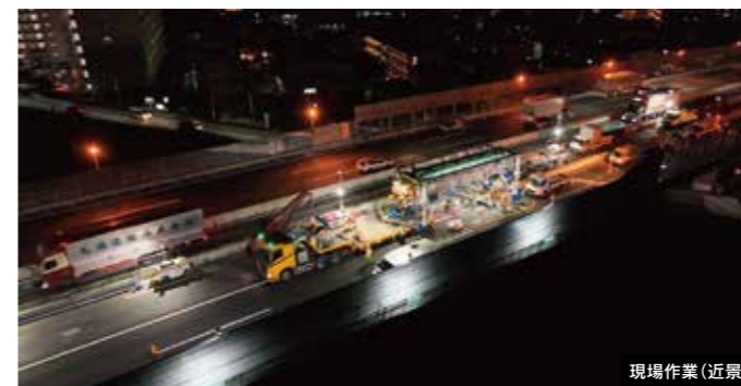
現場作業(近景)
