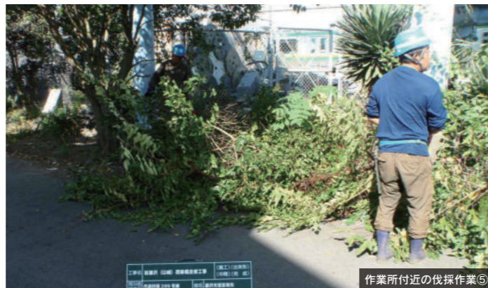
作業所付近の伐採作業⑤
