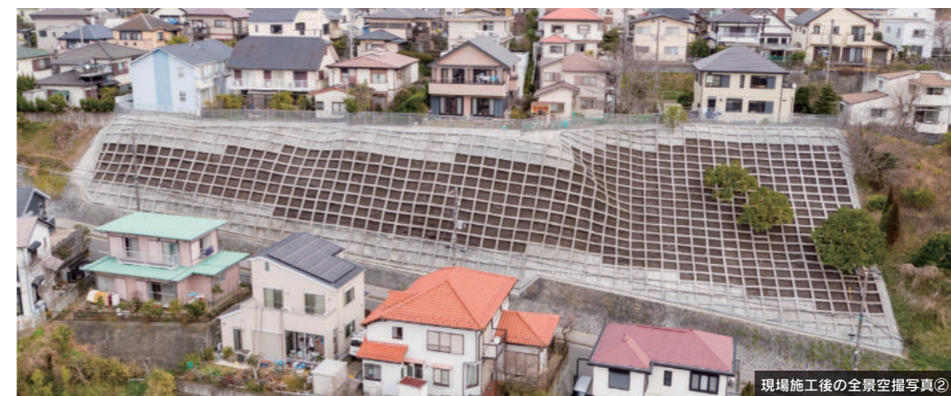
現場施工後の全景空撮写真②
