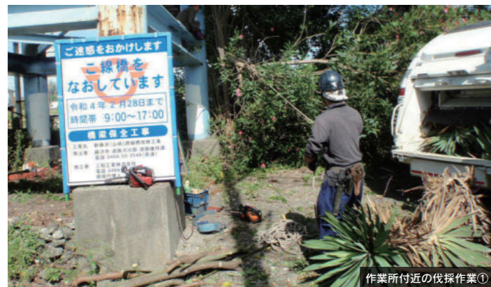
作業所付近の伐採作業①
