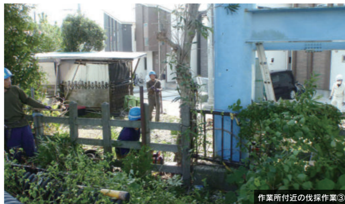
作業所付近の伐採作業③
