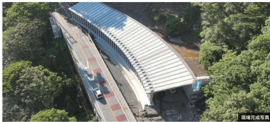
現場完成写真
