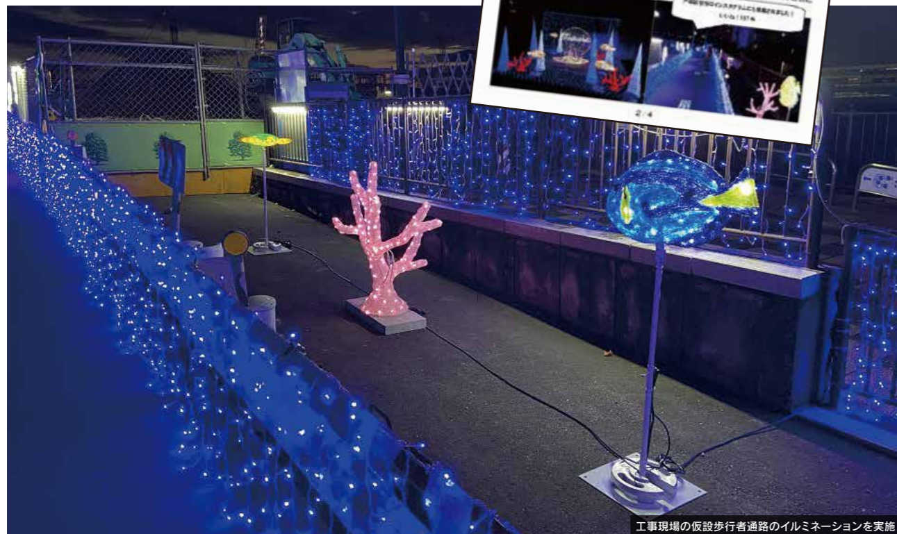
工事現場の仮設歩行者通路のイルミネーションを実施
