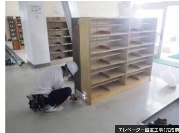
エレベーター設置工事(完成前)
