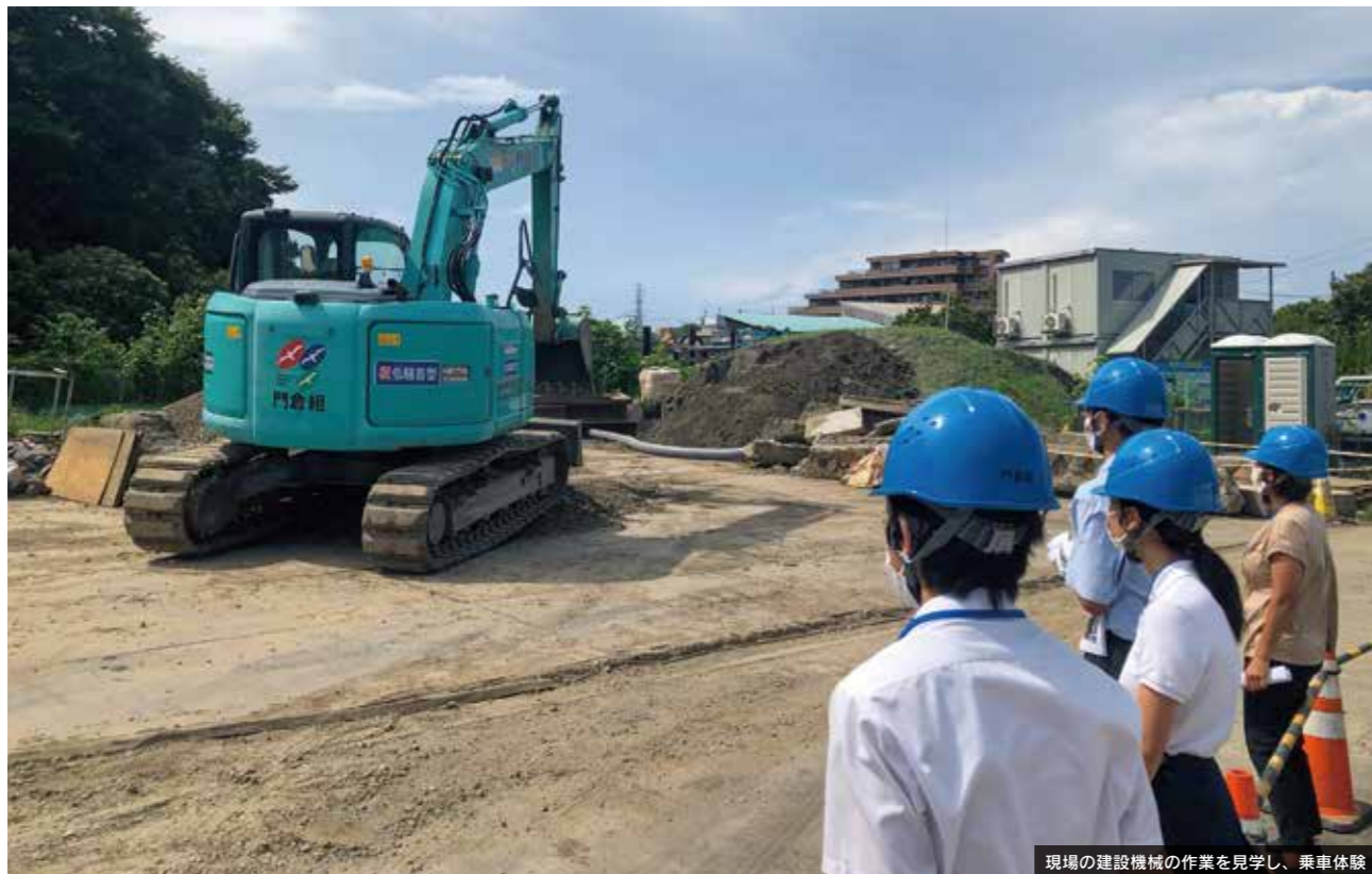
現場の建設機械の作業を見学し、乗車体験
