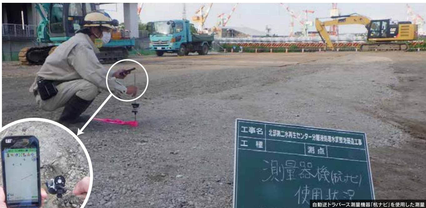
自動逆トラバース測量機器「杭ナビ」を使用した測量
