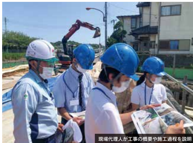
現場代理人が工事の概要や施工過程を説明
